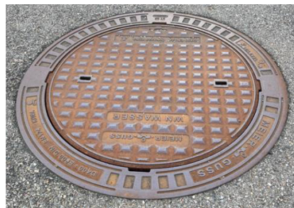
Typischer Unterflurhydrant Foto: FFW
